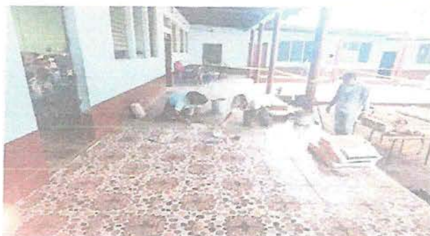
Foto 4: Se muestra la colocación del piso cerámico.
