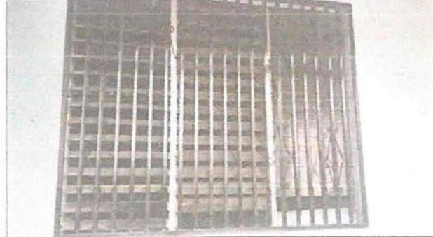
Foto 8: Se muestra el proceso de colocación de valcones de metal.
