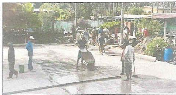
Foto 11: Se muestra el proceso de cambio de torta de la cancha de basquetbol.
