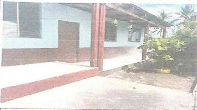
Foto 3: Se muestra la preparación del área donde se colocará el piso cerámico.
