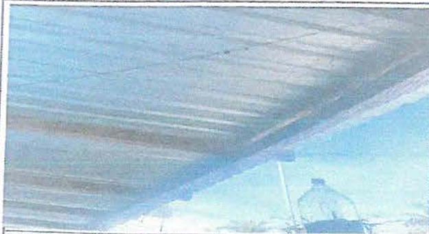
Foto 1: Se muestra el proceso de colocación de lámina traquelada.
