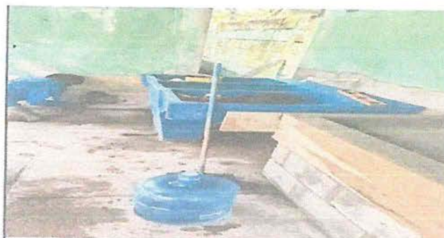
Foto 6: Se muestra la fase de construcción de los lavamanos.
