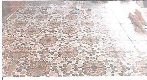
Foto 10: Se muestra el proceso de colocación de piso cerámico en el aula de parvulos.
