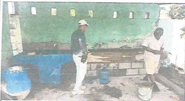
Foto 5: Se muestra el proceso de la elaboración del área de lavamanos.
